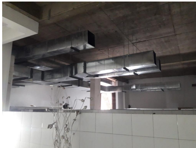
Dokumentasi progres ducting dapur. Koordinasi teknis menjadi bagian penting sebelum penyelesaian ruang. Foto: arsip Gastro F&B.
